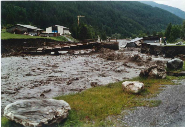
pont de la zone artisanale sur la commune d'Aiguilles
