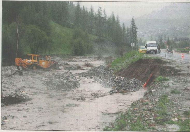
Des engins à l'œuvre pour éviter que l'Aigue blanche ne coupe la route qui relie Molines à Saint-Véran (photo DL / Valérie GARCIN).
